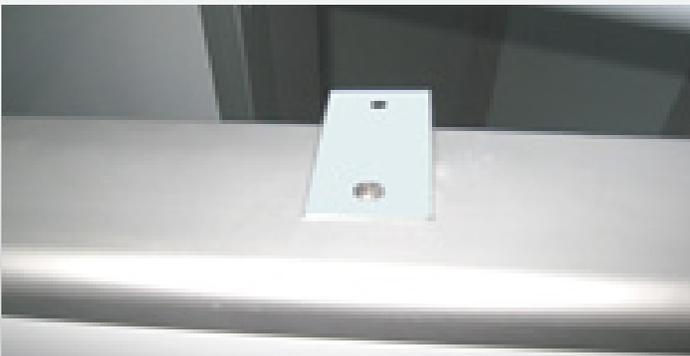
6.) Das Befestigungsblech mit den ersten beiden Schrauben anbringen.
